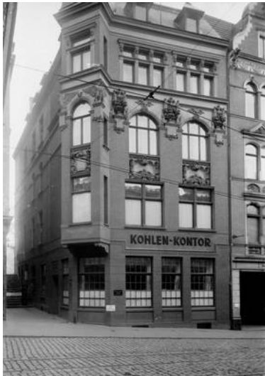
Holstenstraße 17 - Foto des alten Gebäudes (Jahr unbekannt) [1]
