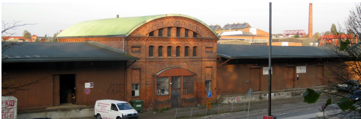
Abb.: Abfertigungsgebäude der Halland-Linie
